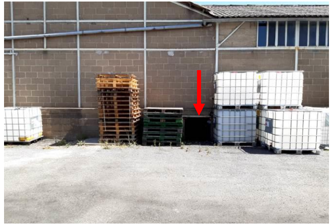
Entrée du sous-sol
