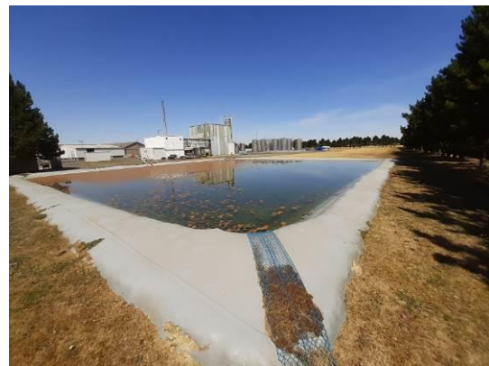
Réserve incendie (zone de reproduction du Triton crêté)
